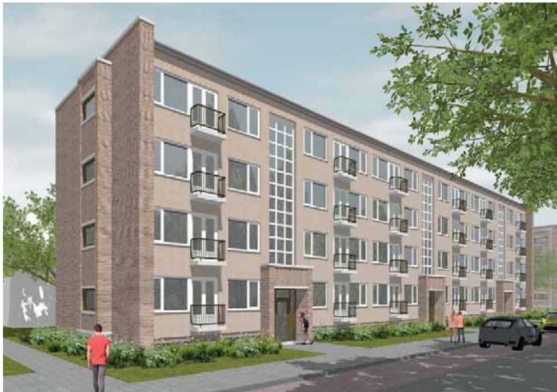
Complex 7 - verbeterde uitstraling 24 portiekwoningen uit 1953 in ZuidWest
