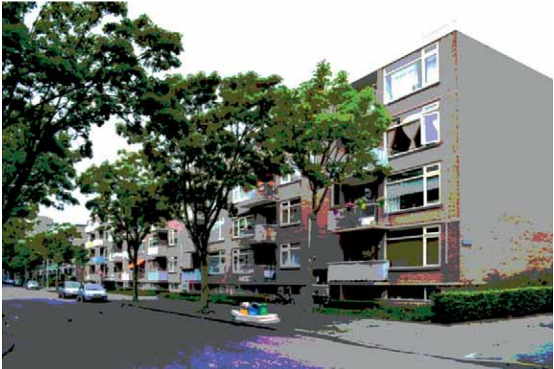
Complex 1 - bestaande situatie 32 portiekwoningen uit 1968 in ZuidWest
