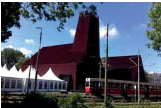
Aardwarmte centrale Den Haag ZuidWest
