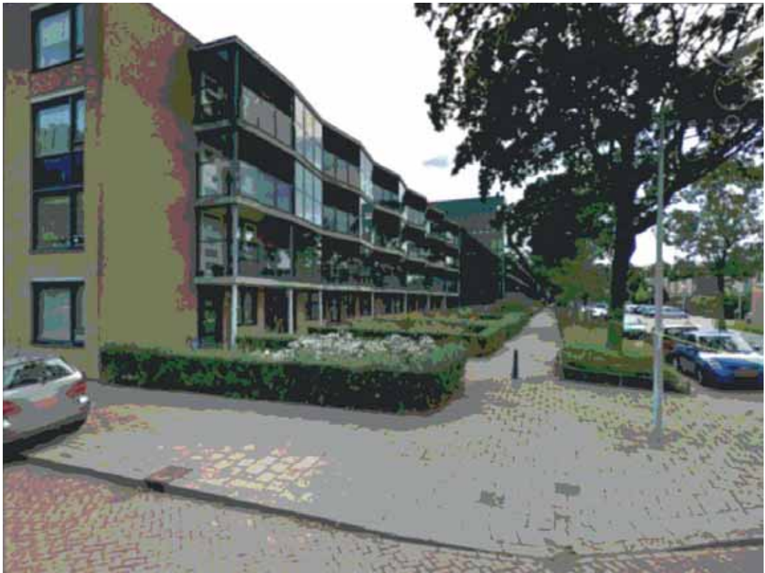
Complex 4 - bestaande situatie 84 galerijwoningen uit 1994 in ZuidWest
