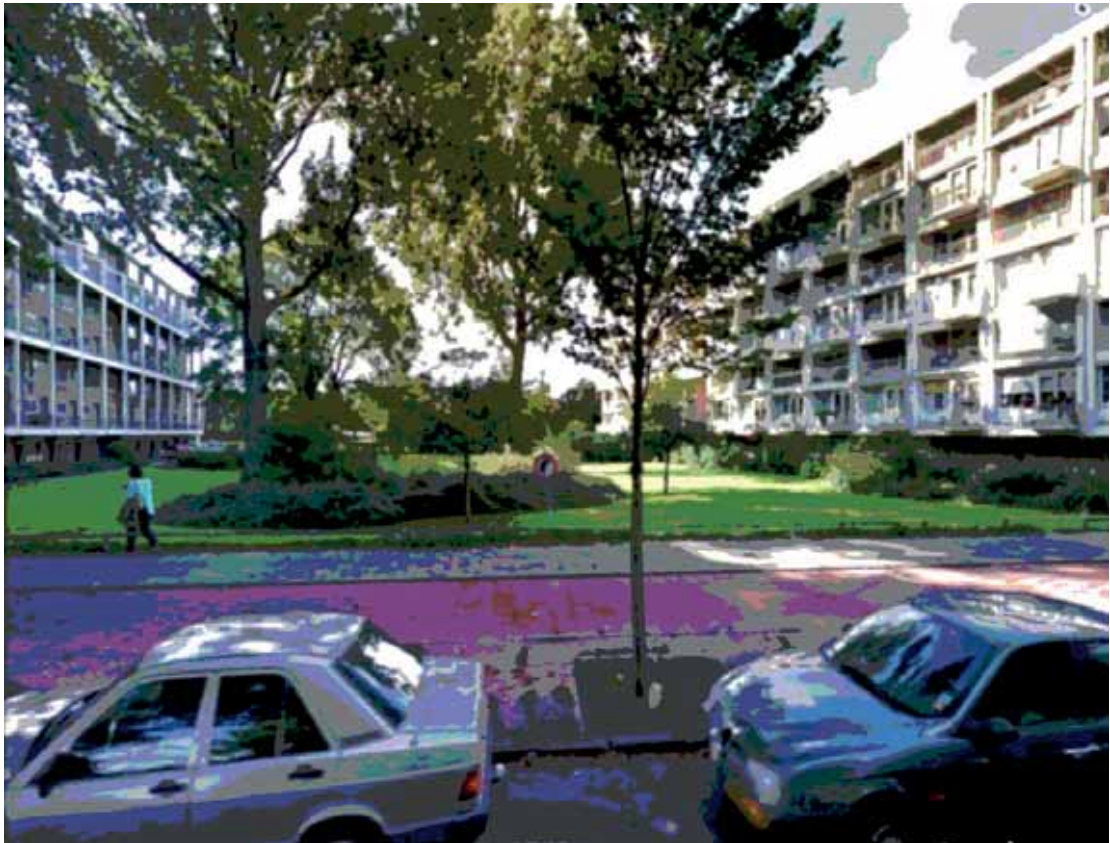
Complex 5 - bestaande situatie 42 maisonnettes uit 1952 in ZuidWest
