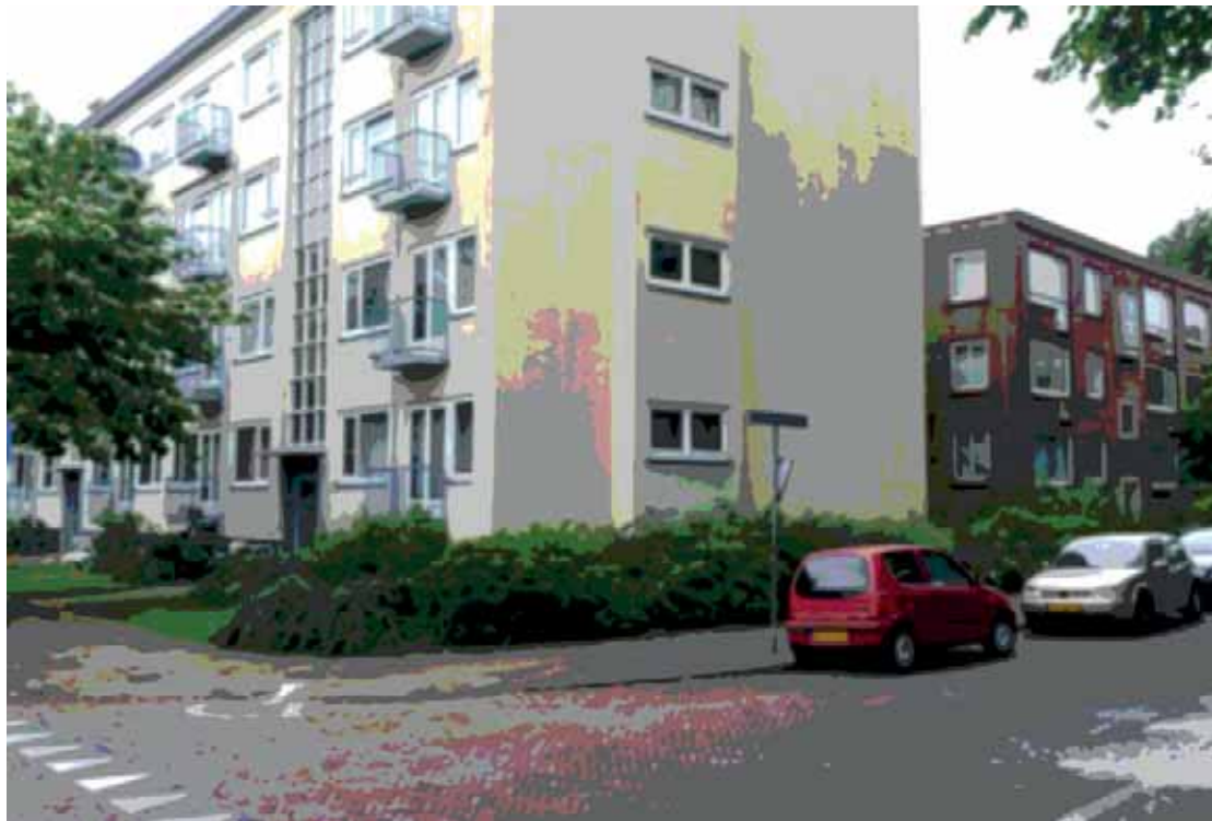
Complex 7 - bestaande situatie 24 portiekwoningen uit 1953 in ZuidWest
