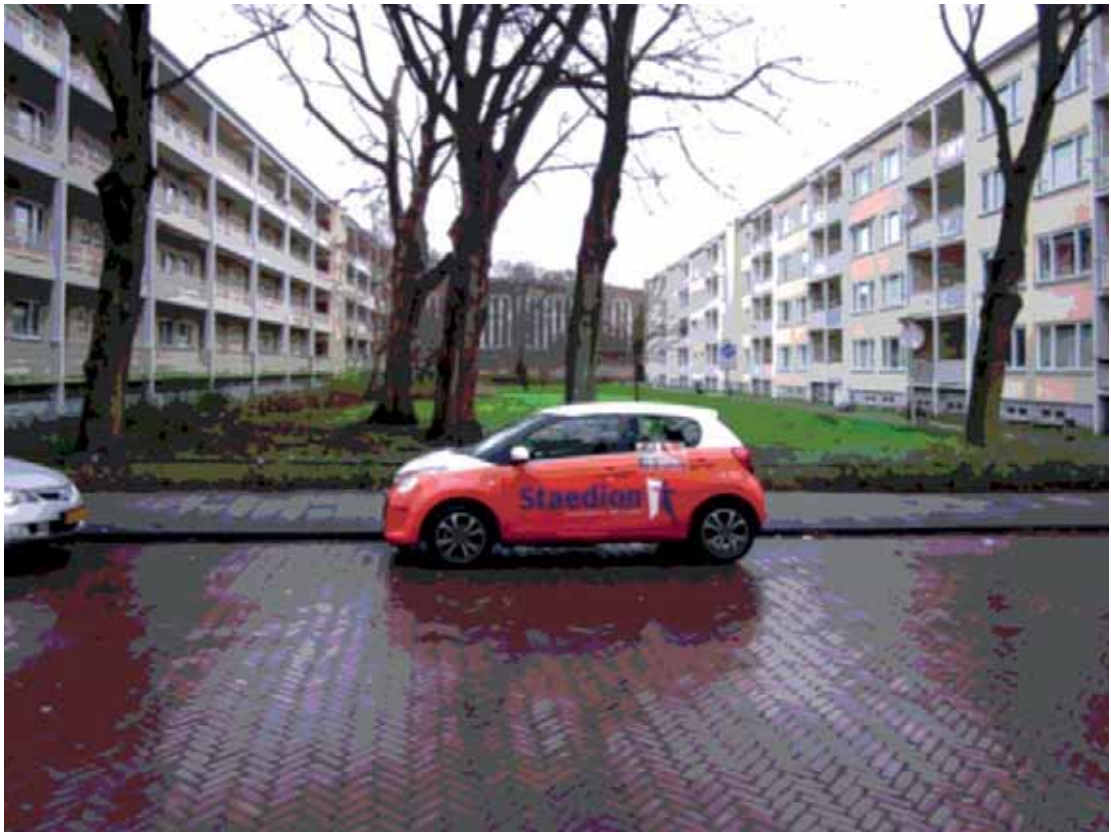
Complex 6 - bestaande situatie 56 galerijwoningen uit 1954 in ZuidWest
