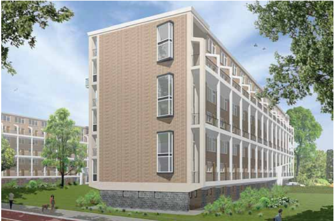
Complex 5: nieuwe entree, kopgevelisolatie en erkers
